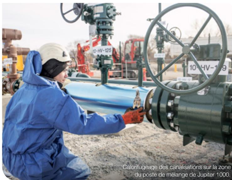
Calorifugeage des canalisations sur la zone du poste de mélange de Jupiter 1000.
