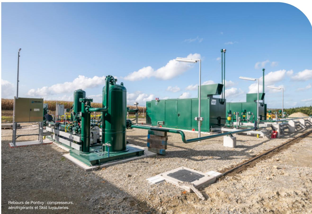
Rebours de Pontivy : compresseurs, aérofrigoriférants et Skid tuyauteries.
